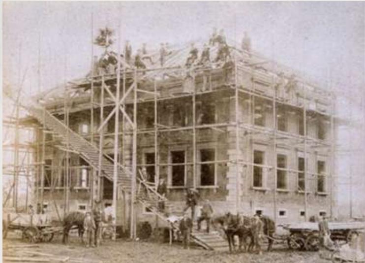
Das neue Schulhaus im Bau 1900
