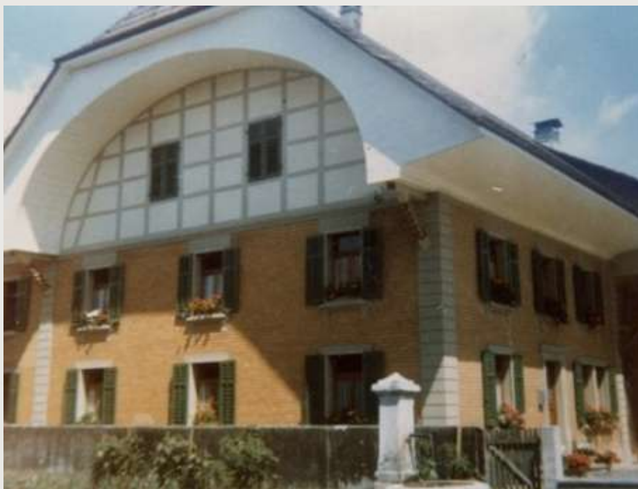
Das Haus vom «Ryche Jäggi» (1976 abgebrannt)
