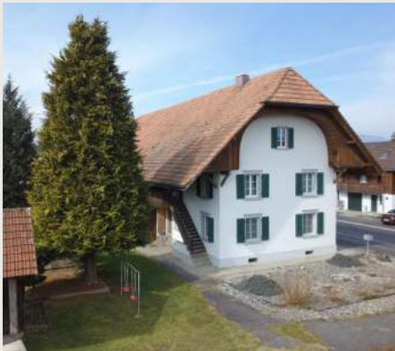
Jäggi-Haus vor dem Abbruch.
