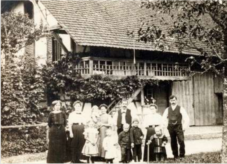
Liegenschaft Heiniger Südringstrasse 18
