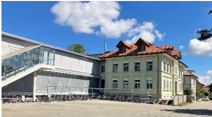
Primarschulhaus in Recherswil
