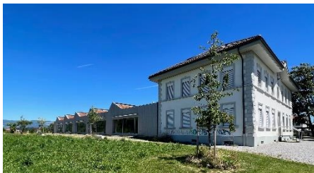
Primarschulhaus in Obergerlafingen mit dem Kindergarten im neuen Anbau
