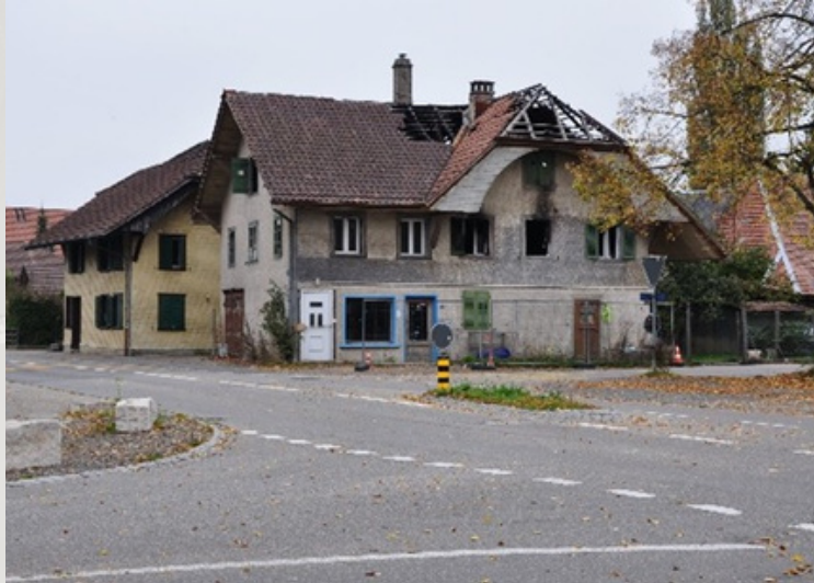
Die Bäckerei Gerber, (Ecke Hauptstrasse/Grundmattstrasse) ist abgebrannt.
