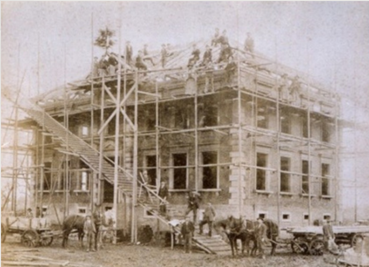
Das neue Schulhaus im Bau 1900
