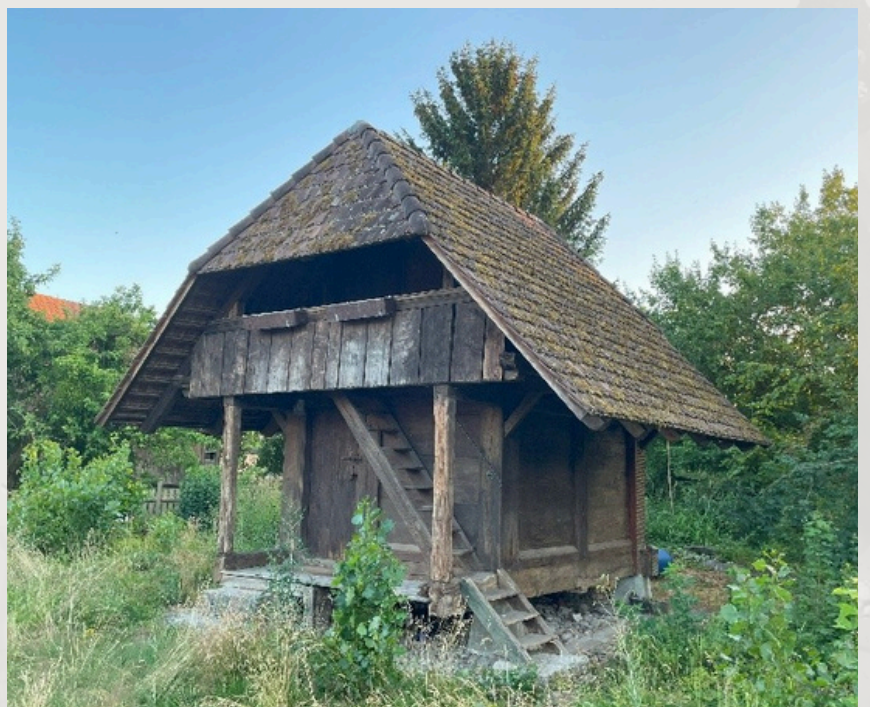
Noch ein kleiner Spycher bei der Grundmattstrasse 15 Anton Stuber
