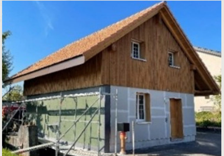
Das Haus wurde abgerissen und komplett neu erstellt.
