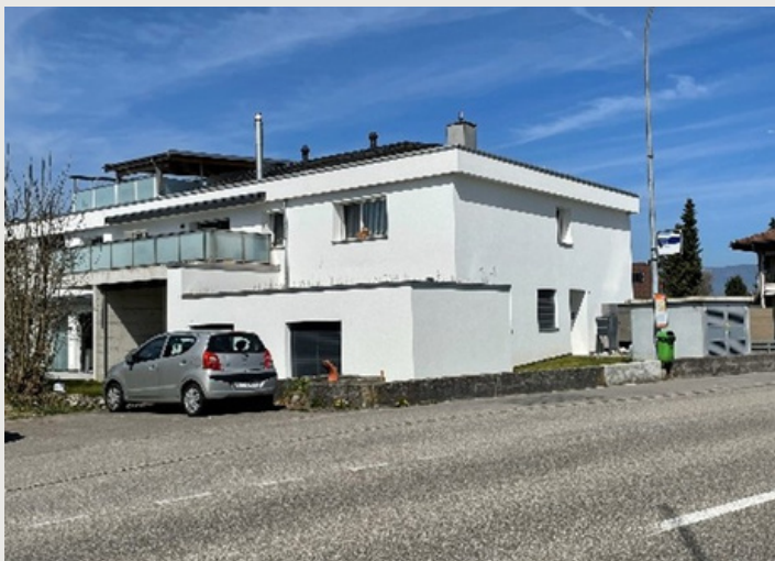
An der Hauptstrasse 14 gab es Arbeit bei der Ingold Präzisionsmechanik. Heute zu einem Mehrfamilienhaus umgebaut.
