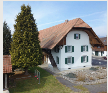
Jäggi-Haus vor dem Abbruch.
