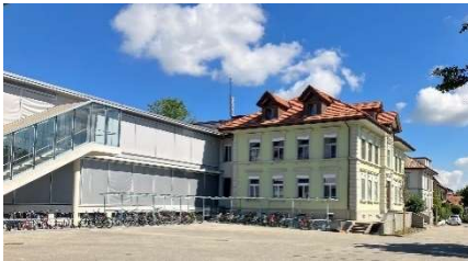
Primarschulhaus in Recherswil mit dem Kindergarten im alten Schulhaus
